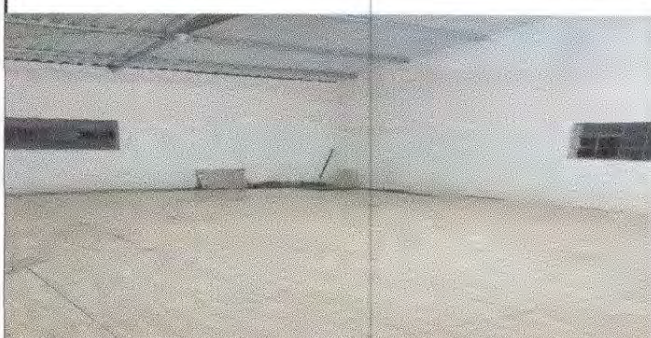
Foto 4: Sustitución de piso de torta de concreto por porcelanato, en la dirección del establecimiento.
