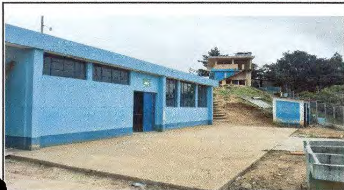
Foto 7: Loma de patio, frente a la cocina escolar del módulo 2
