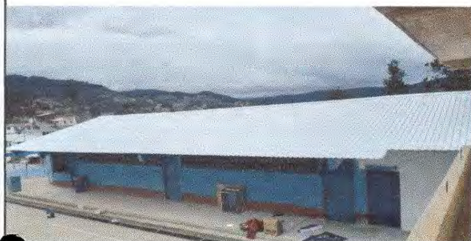
Foto 1: Sustitución de lámina por lámina troquelada aluzinc calibre 26, en dos aulas del módulo 1 y dirección del establecimiento.
